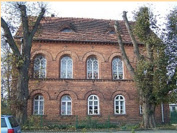
Kaszczor, ul. Sportowa 1 (dawne przedszkole) Budynek o powierzchni użytkowej około 200 m 2
